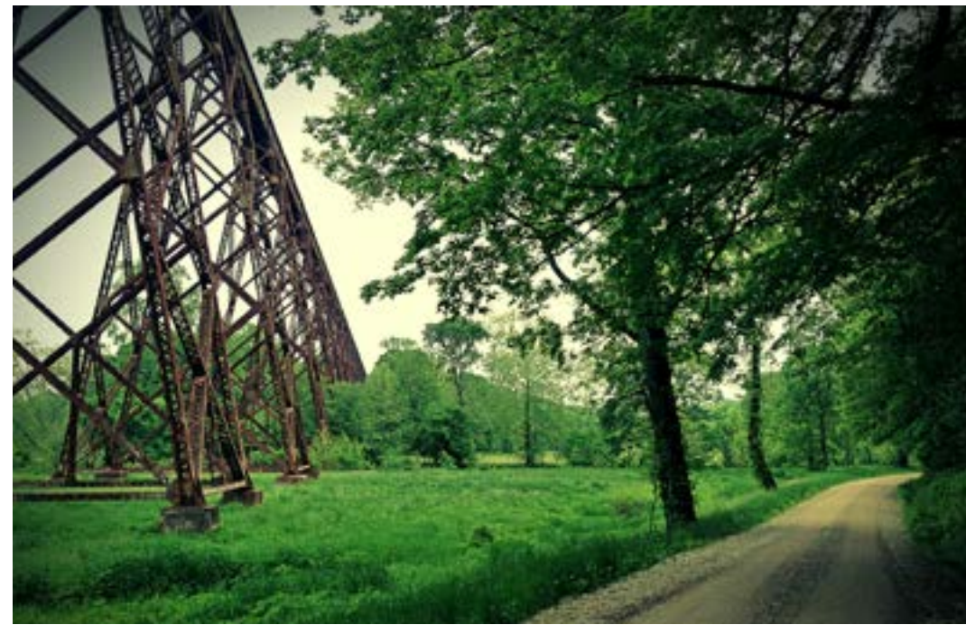
(1.) Tulip Trestle/ Viaduct
